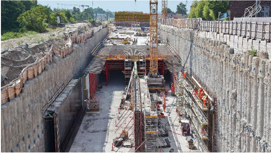
Nordhavnsvej Tunnel, Copenhagen, Denmark, Aug. 2013
